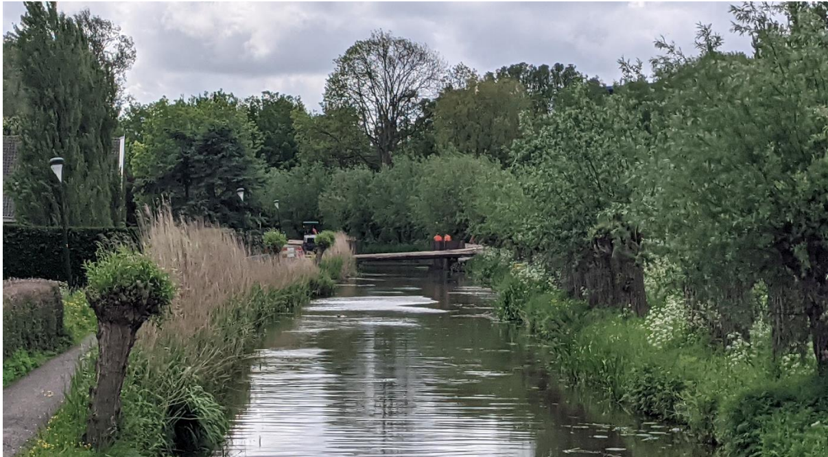
Figuur 3-4: Vervanging van één van drie bruggen over het Nieuwe Water, Maassluis
