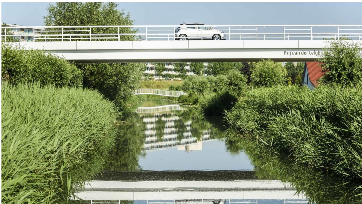
Foto 16: Arij van der Lely brug, Maassluis
