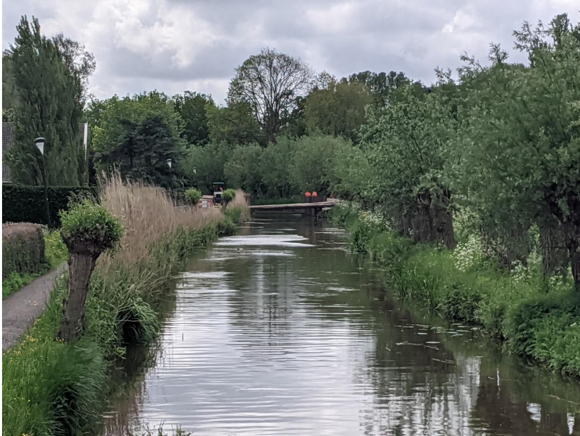
Foto 9: Geplande vervanging drietal bruggen over het Nieuwe Water, Maassluis 2021
