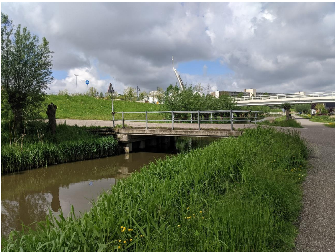
Foto 10: Brug over het Nieuwe Water, Maassluis 2021
