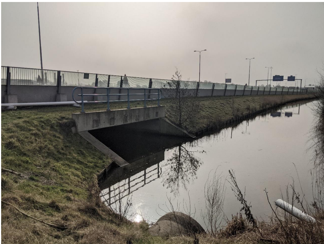
Foto 12: Duiker verkeersplein, Westerlee 2021
