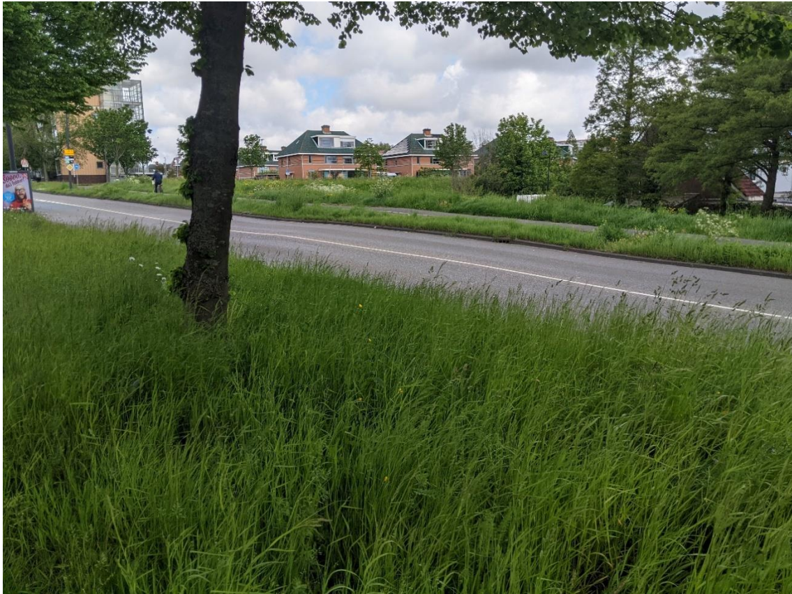
Foto 5: Verzakking wegdek duiker Westlandseweg/Rozenlaan, Maassluis 2021
